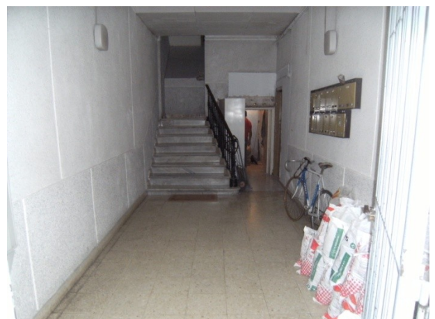
FOTO 4. Vestíbul de l'immoble. Al final es pot veure el lloc de la intervenció
