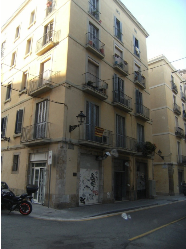
FOTO 1. Vista general de l'immoble
