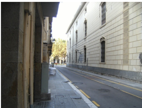
FOTO 3. Vista general del carrer amb la façana posterior de l'edifici de la Subdelegació del Govern
