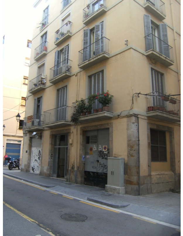
FOTO 2. Vista general de l'immoble
