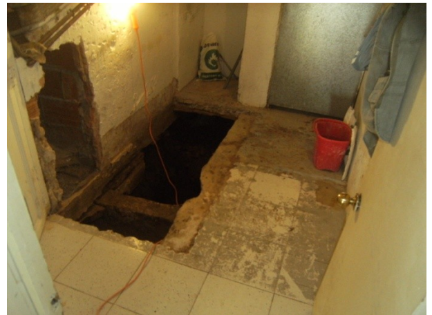
FOTO 8. Estat final de la rasa un cop finalitzades les tasques d'excavació
